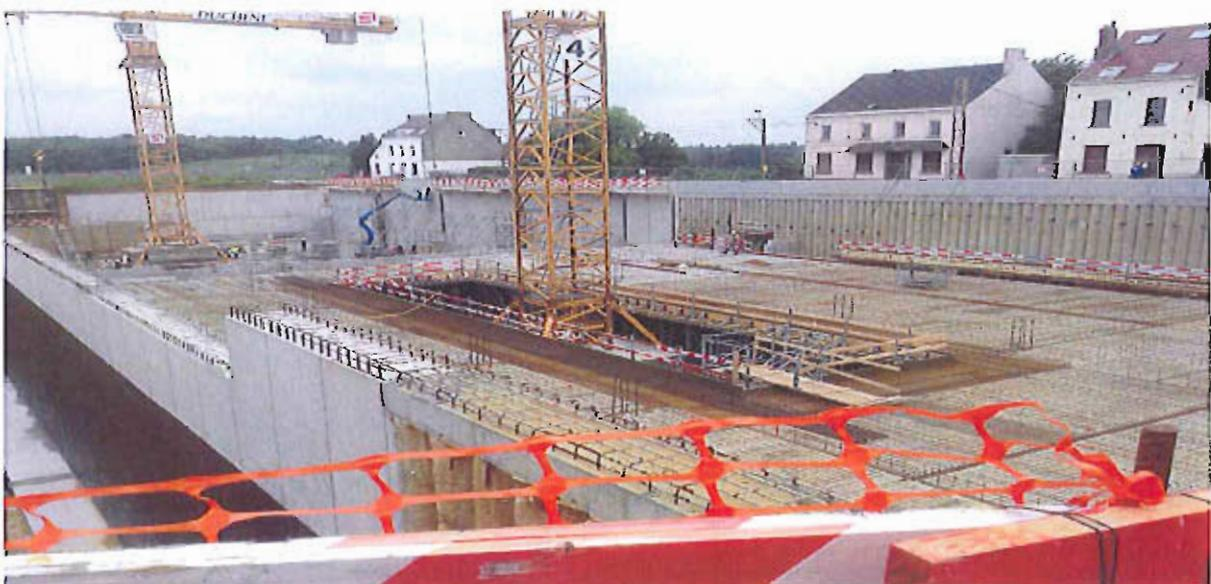
Ensuite furent élevés les murs latéraux avec des voiles de béton avant l'installation de la fondation, la construction des murs intérieurs, des colonnes de soutien et l'implantation d'un bassin d'orage qui peut accueillir à peu près 200 m<sup>3</sup> d'eau destinée à alimenter les sanitaires.
