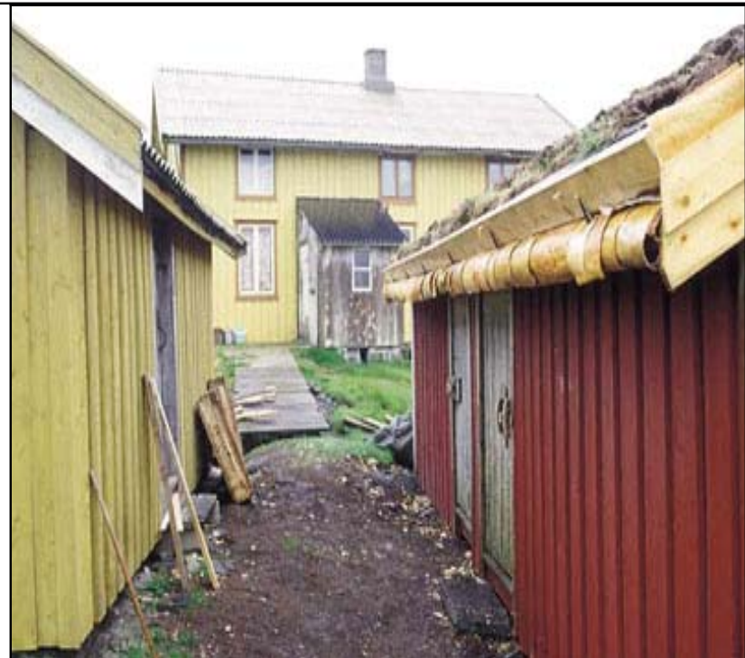
ETTER Istandsetting Ordinært vedlikeholds nivå
