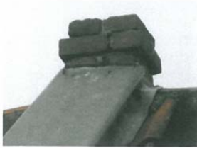
zink in het zicht genageld. gevel no. 2
